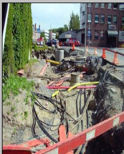
Entreprenøren har ansvar for å halde oversikt over kva som ligg i grunnen der det skal gravast.
