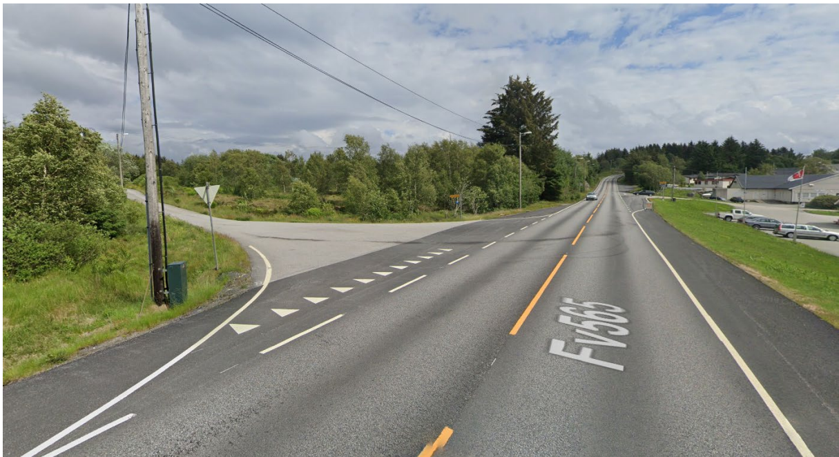
Eksisterende kryss, Austrheimvegen – Leirvågsvegen, retning øst.
